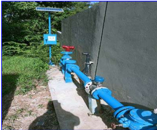
รูปที่ 2.27 หัวรับน้ำ และหัวจ่ายน้ำดับเพลิง
