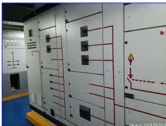
รูปที่ 2.29 ตู้ MDB Main Distribution Board
