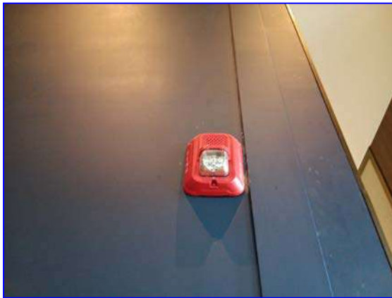
รูปที่ 2.24 อุปกรณ์ส่งสัญญาณแจ้งเหตุเพลิงไหม้
